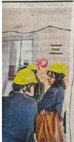
Il luogo nel cantiere
